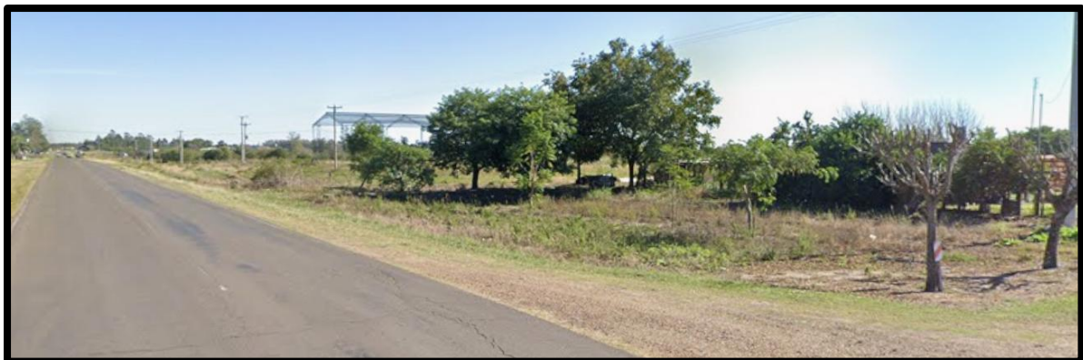
Figura 13 –Zona del proyecto. Imagen de Google Maps
